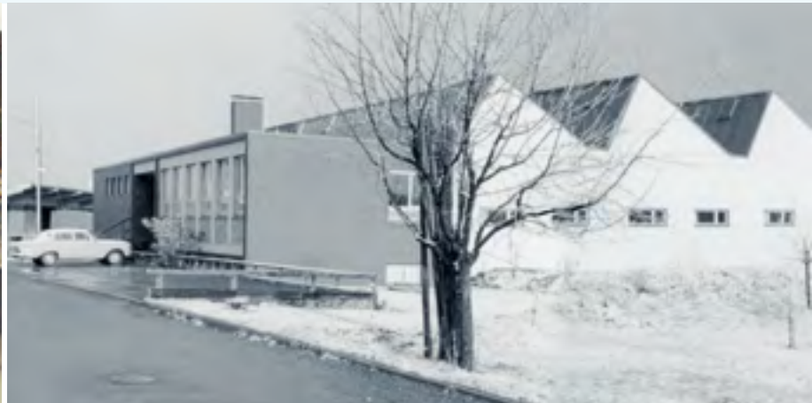
Neubau 1963 in Großheppach im Remstal
